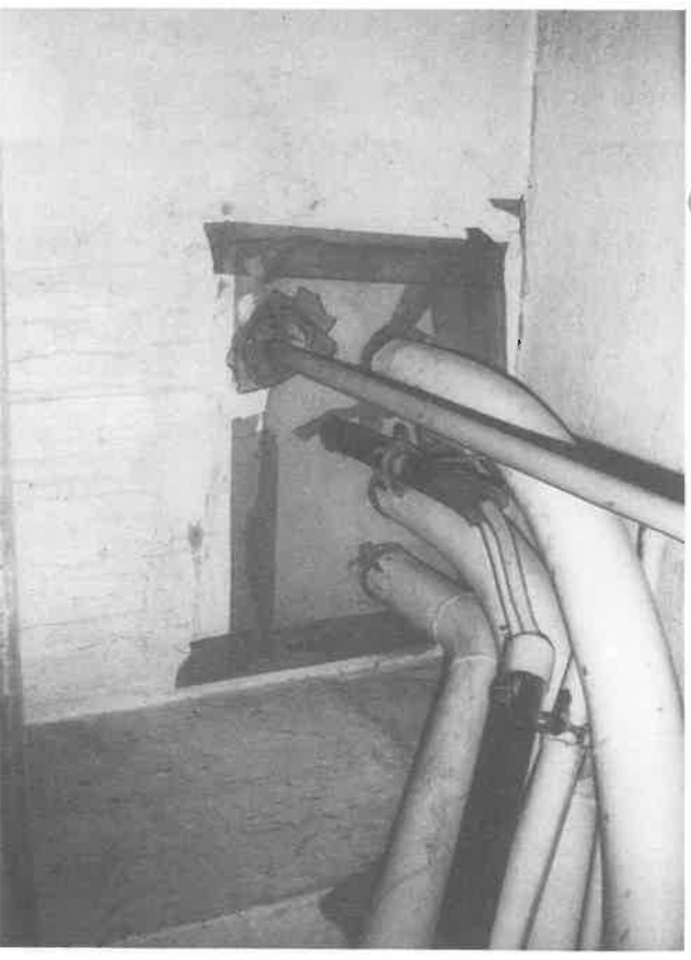
Abb. 3: Abklebung von Rohrleitungs-Wanddurchführungen mit Spezialpapier und Tapetenkleister
