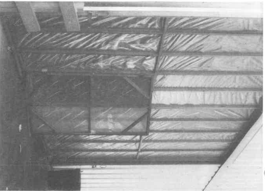
Abb. 2: Rahmenkonstruktion, bespannt mit gasdichter, gitterverstärkter Folie zum Abdichten eines großen Rolltores
