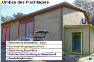
Umbau des Flachlagers
